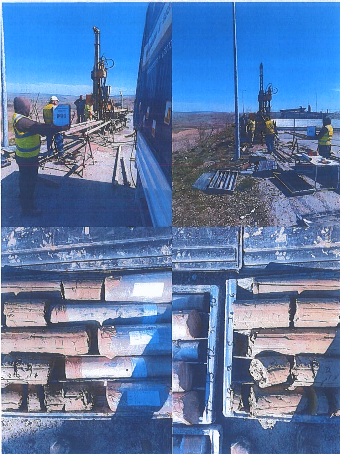
Figura 4.3.1. Realizare foraj și prelevare probe – Foraj geotehnic F01
