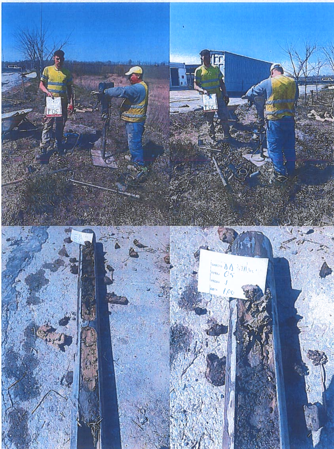
Figura 4.3.5. Realizare foraj și prelevare probe – Foraj geotehnic f05
