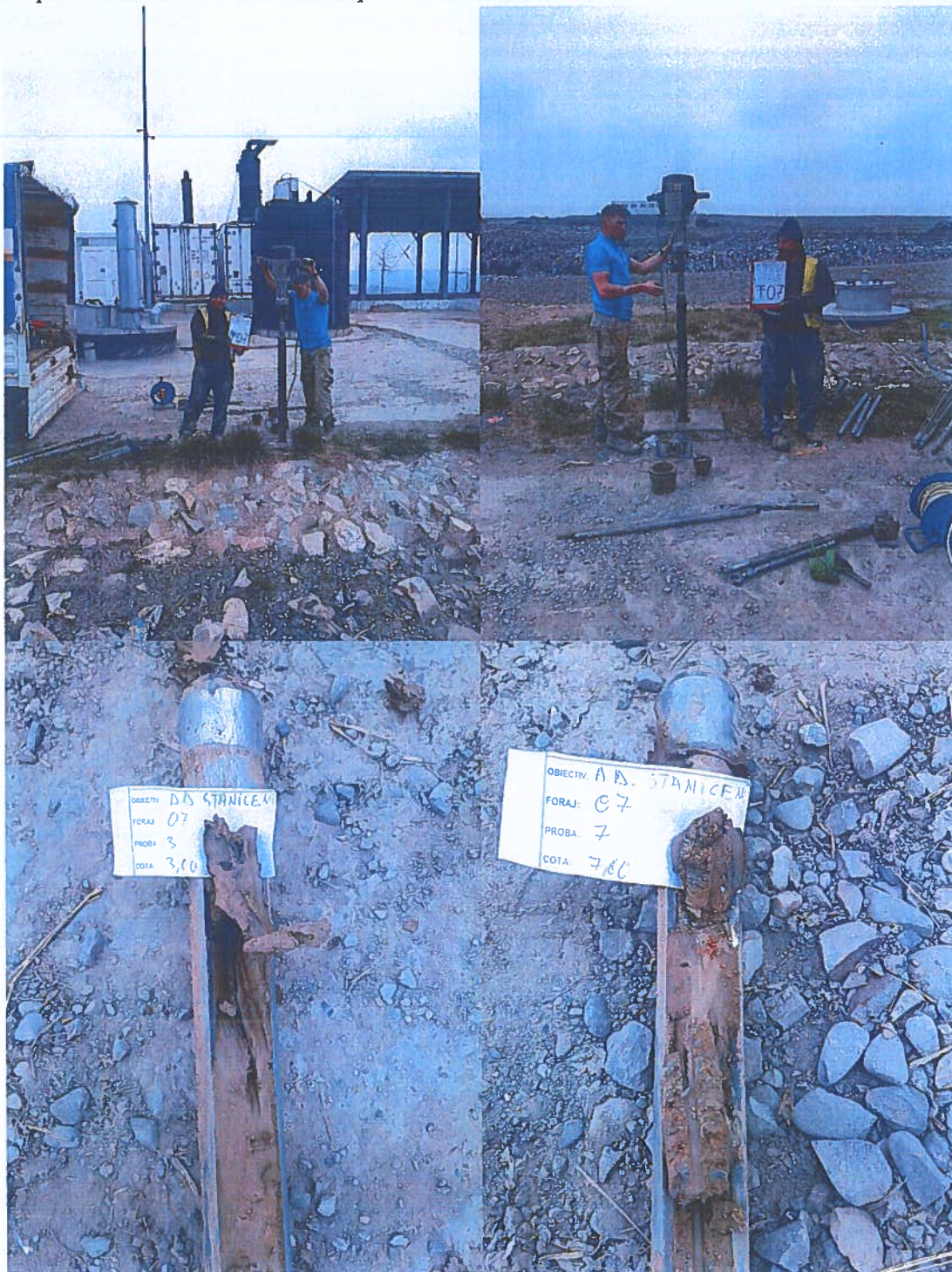
Figura 4.3.7. Realizare foraj și prelevare probe – Foraj geotehnic f07
